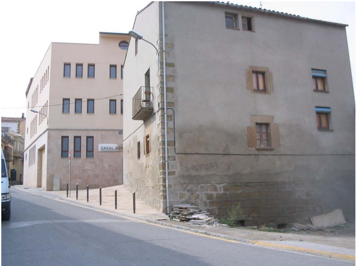
Ronda Comtes d'Urgell. En primer terme, casa destinada a habitatge amb qualificació I2; darrera, façana posterior de l'ampliació del Casal.
